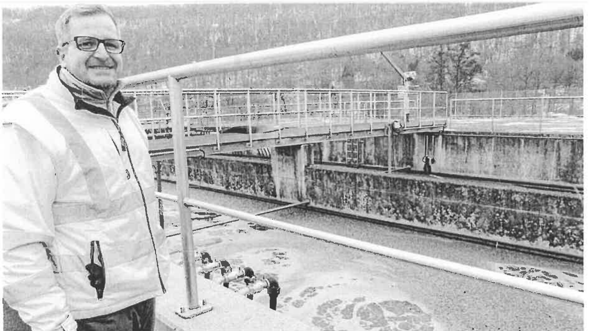
Im Denitrifikations- und den darauffolgenden Belebungsbecken bauen die Mikroorganismen Ammoniumstickstoff, Nitrat und Kohlenstoffe ab.
